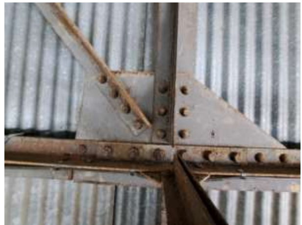
10 – Assemblage du treillis par rivets et boulons
