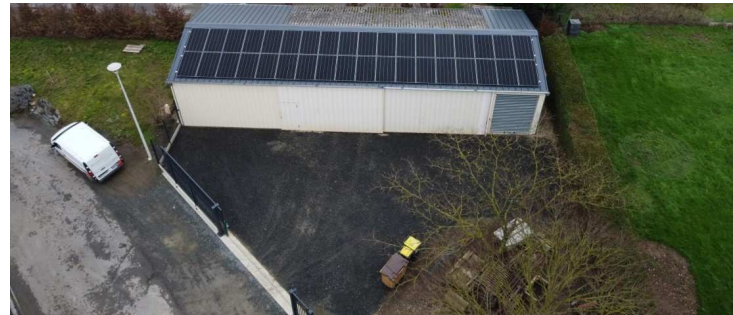
Cernusson – Installation de panneaux photovoltaïques sur la toiture du local technique
