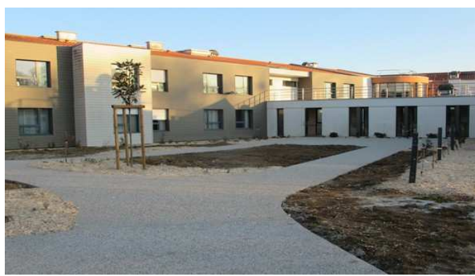
Après les travaux
