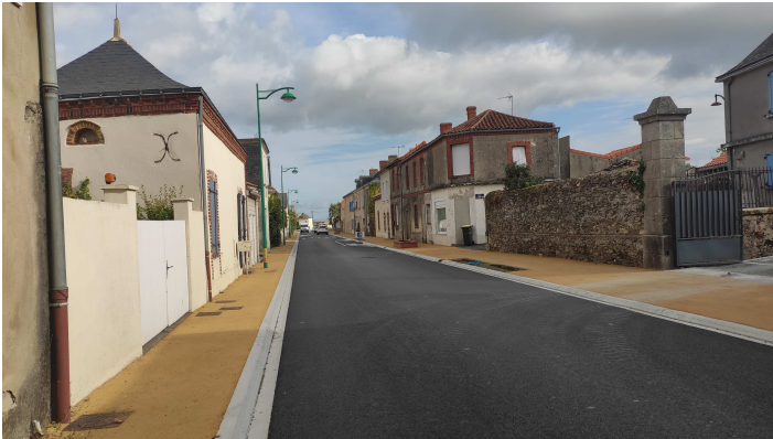
Montilliers – Trottoir en enduit reflétant la chaleur
