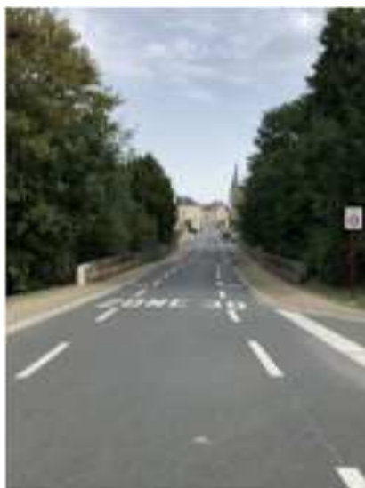
Trémentines – Réalisation d'un chaudiou
