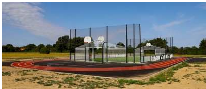
Nuailly – Construction d'un city stade
