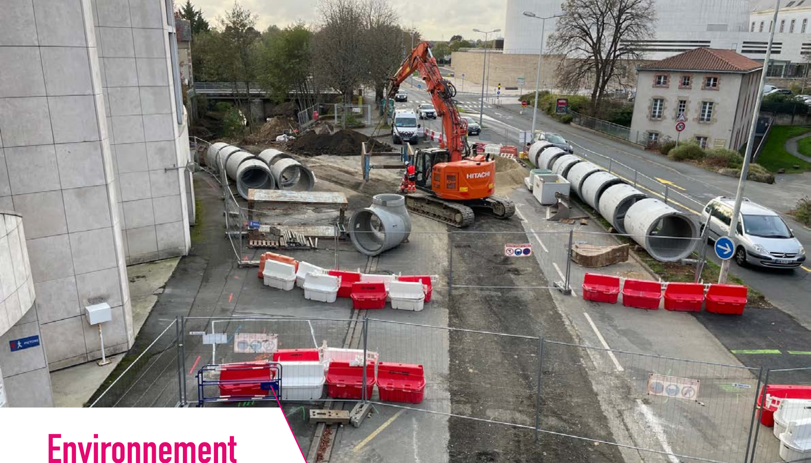
Travaux d'assainissement, rue de l'Abreuvoir (Cholet)
