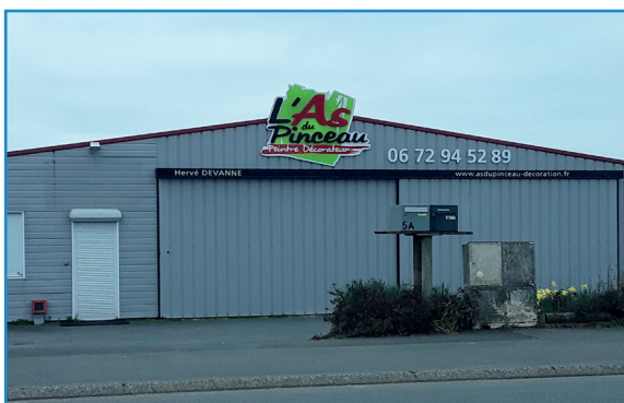
Enseigne murale dépassant du mur (article R.581-60 du Code de l'environnement). En abaissant celle-ci, elle devient conforme – La Tessoualle
