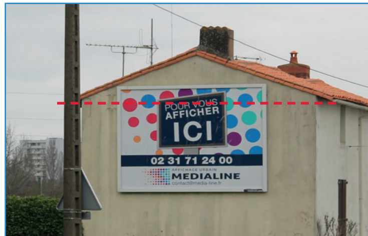
Publicité dépassant de la limite de l'égout du toit (article R. 581-27 du Code de l'environnement)
