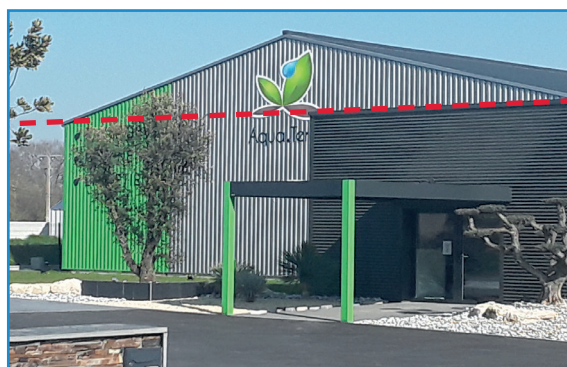
Enseigne apposée à plat dépassant les limites de l'égout du toit (article R. 581-60 du Code de l'environnement) – Saint-Paul-du-Bois
