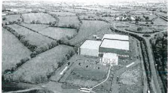
Le futur centre de tri envisagé sur le site de la Croix à Loublande - La Tessoualle.
