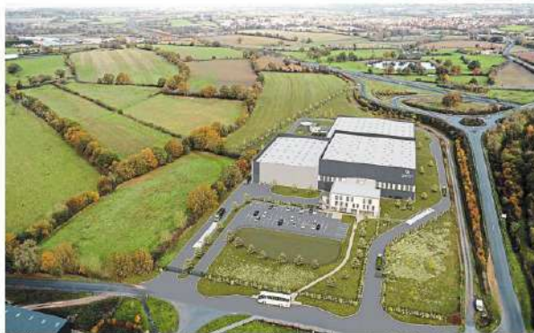
Le début des travaux du centre de tri des déchets recyclables, à cheval entre Loublande et La Tessoualle. (Photo: Courrier Ouest)
