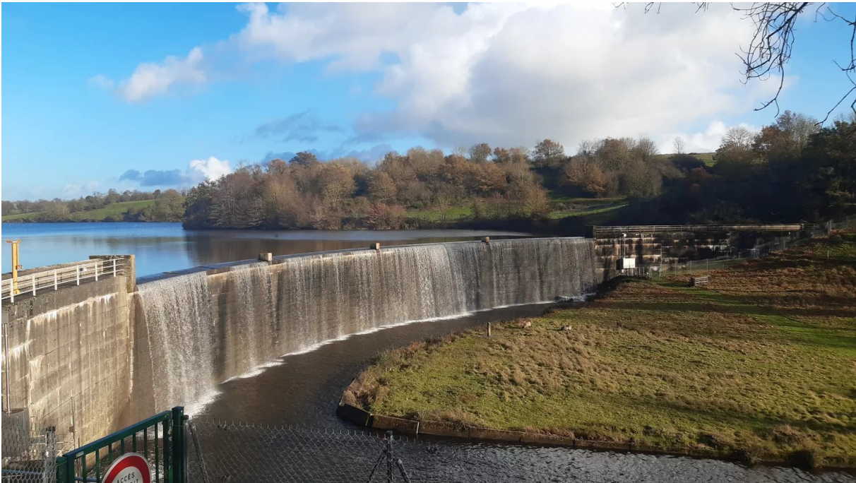
Surverse au barrage de Ribou le 8 décembre 2023.
