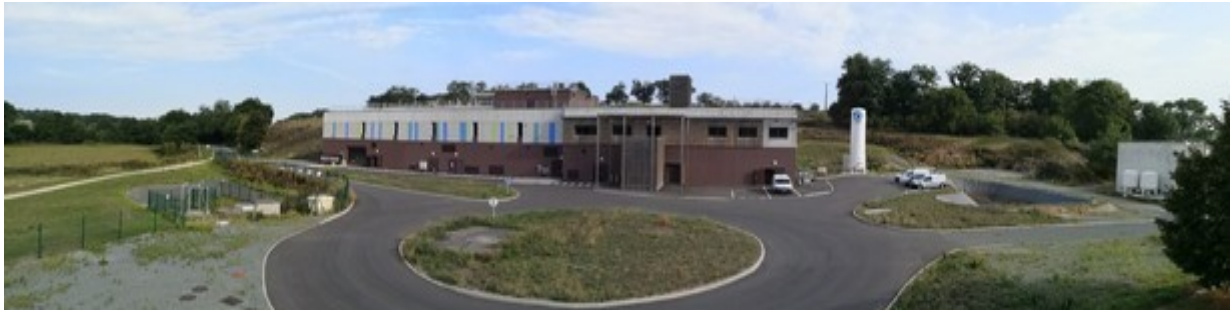
Bloc de traitement T4 de l'usine de Ribou (2019)
