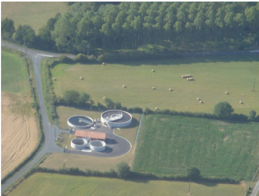
Station d'épuration de Trémentines
