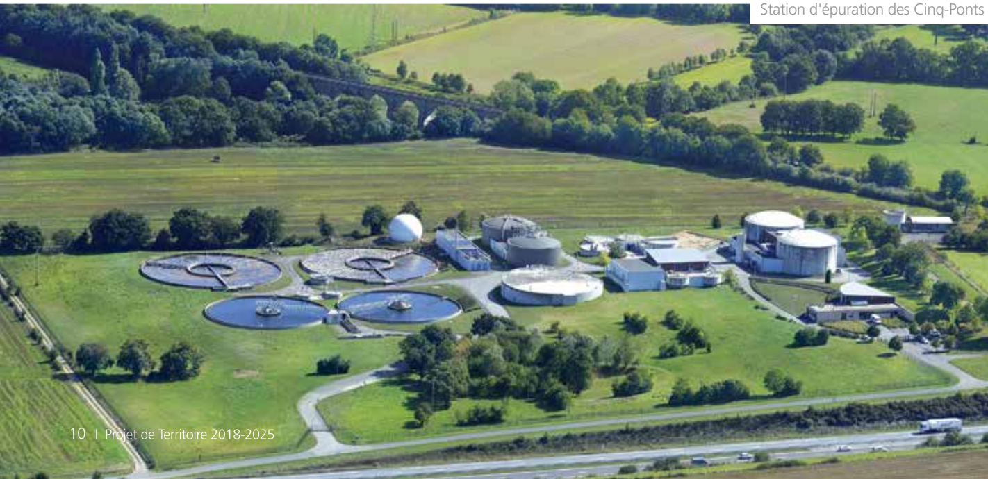
Station d'épuration des Cinq-Ponts
