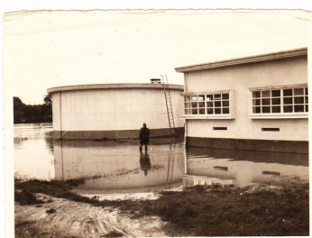
4 Novembre 1960 Inondation du site de la station de pompage de la Rucette par la rivière l'Ouin
